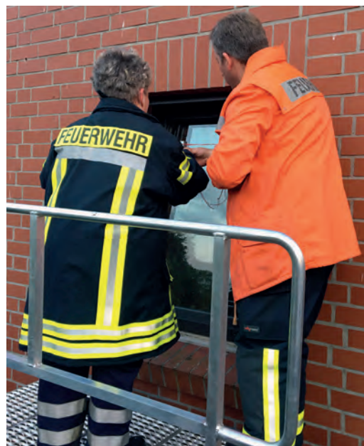
Foto: Station 2 Fensteröffnung
